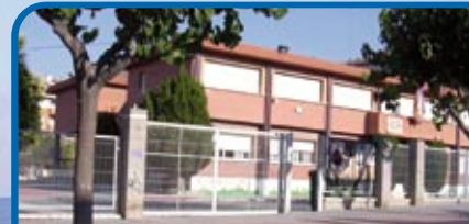
Ampliación y remodelación integral del CP Virrey Poveda. Inversión: 6.500.000 €.
